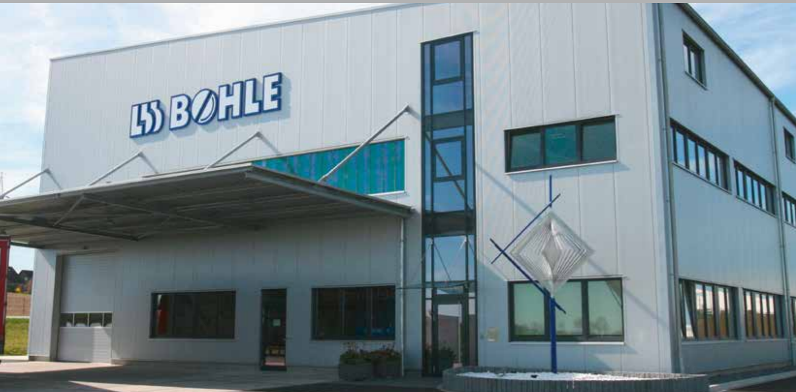
Das neue Werk 3 in Ennigerloh
